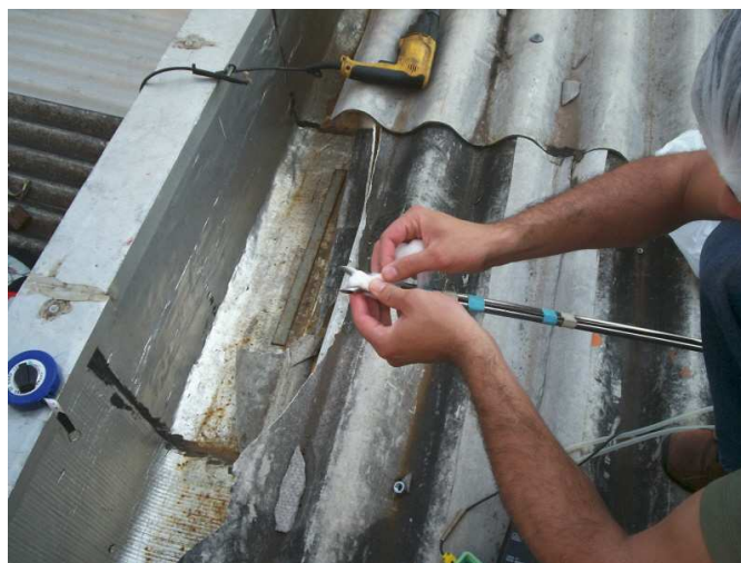
Figura 12 – Fixação de algodão na ponta do Pitot.
