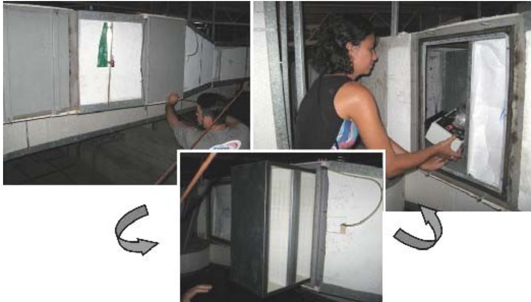
Figura 26: Amostragem no sistema de ar condicionado
